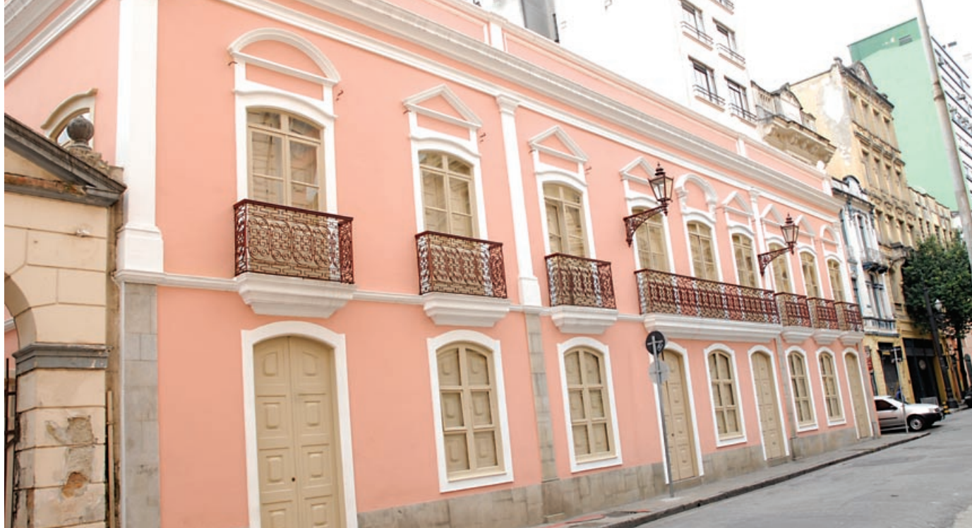
SOLAR DA MARQUESA
